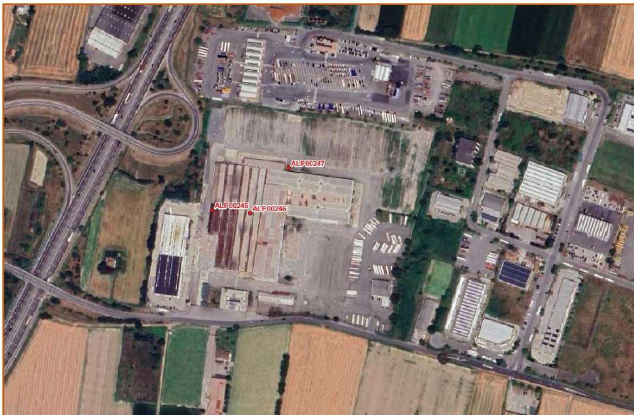
Figura 2 Vista aerea di dettaglio dello stato di fatto
