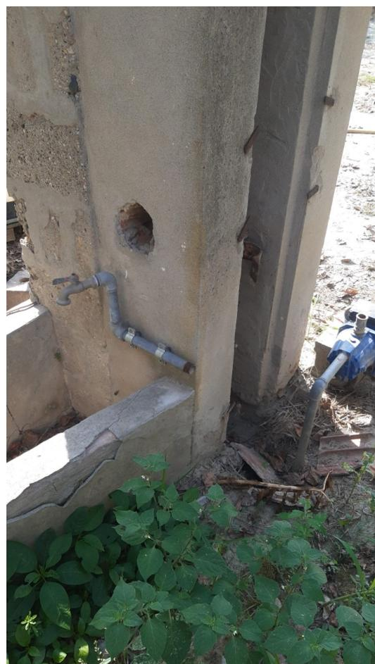
Il pozzo in questione costituito da un "tubo piantato a terra" risulta chiuso dall'alluvione 2000 e non più utilizzato, anche la pompa esterna, posizionata in prossimità, è sprovvista di tubazione di collegamento al rubinetto. **Sulla base di tali caratteristiche (fornite dalla proprietà) si esclude dalla CONCESSIONE tale opera di captazione.**
