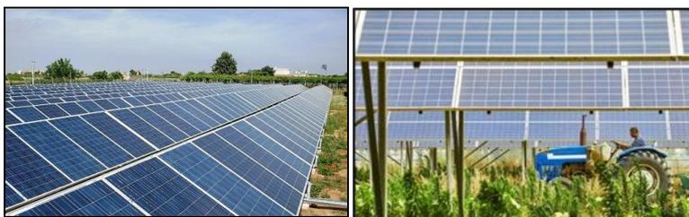
Figura 61- Sistema fisso standard e sopraelevato
