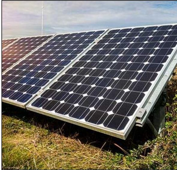
Figura 132 - Impianto fv con moduli di tipo monocristallino
