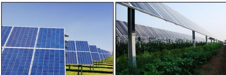
Figura 62 - Monoassiale inseguitore di rollio standard e sopraelevato
