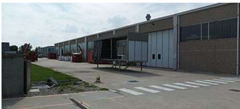
AREA POZZO IRRIGAZIONE AREE VERDI/SERVIZI IGIENICI
