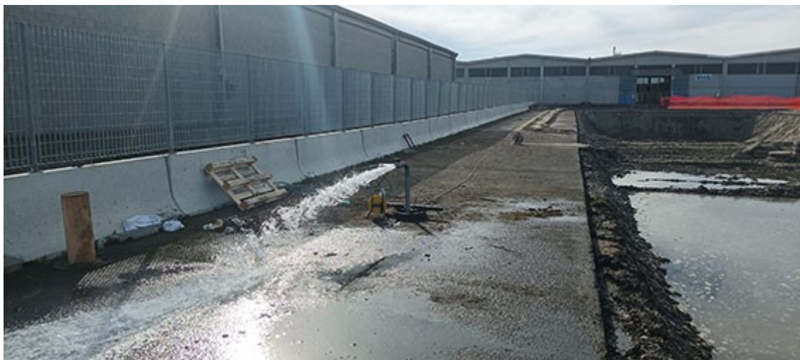
AREA POZZO CIVILE (PROVA DI PORTATA)
