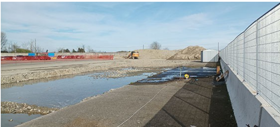
VISTA SUD AREA POZZO CIVILE
