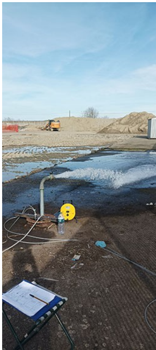
AREA POZZO CIVILE (PROVA DI PORTATA)
